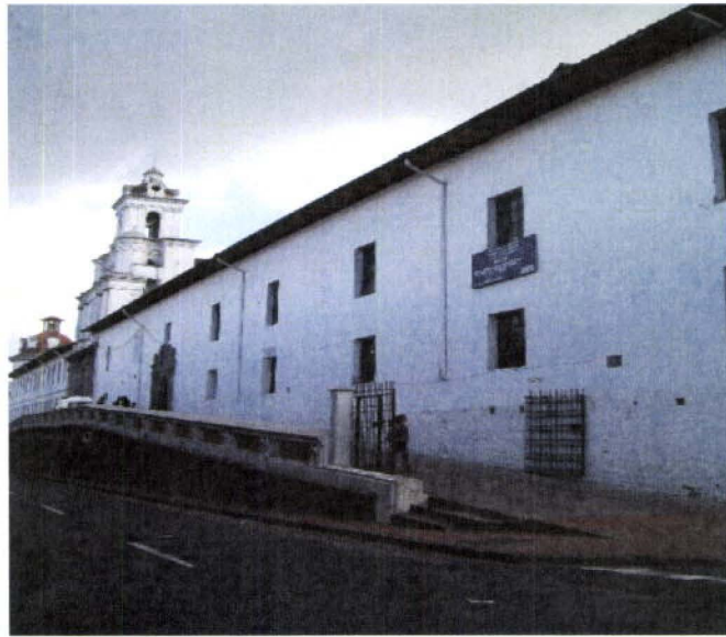
Figura 7. Vista exterior del bloque. Acceso peatonal.
