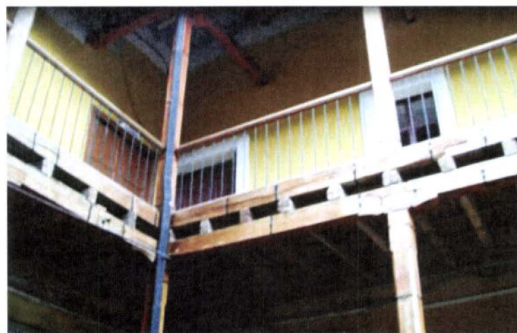
Figura 8 Estructura de madera y carrizo en entresijos
