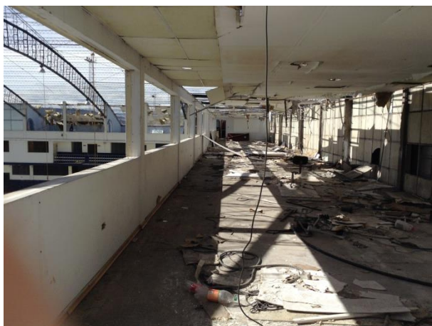
Figura 18. Vista interior del espacio en el tercer piso.
