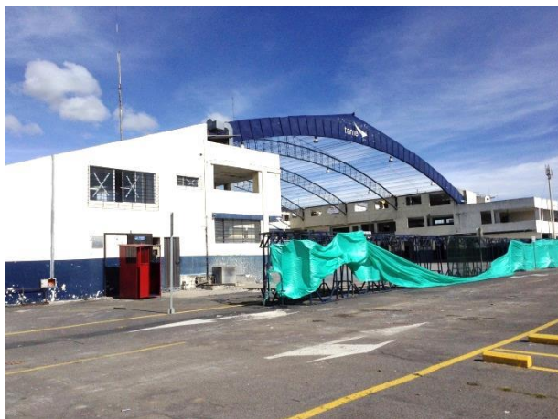
Figura 114. Fotografía de la fachada posterior de la edificación.
