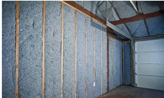
Figura 61. Recubrimiento de paredes.
