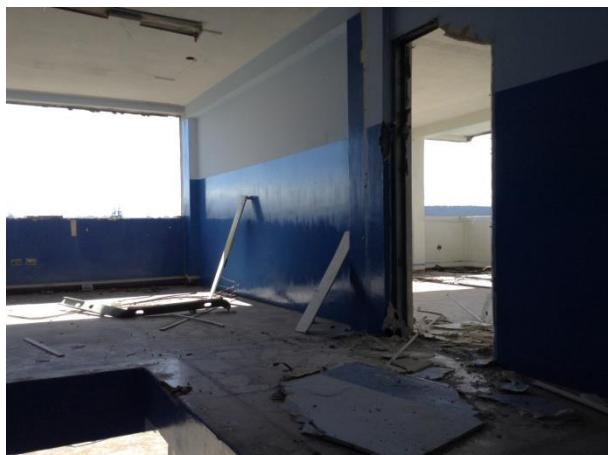
Figura 13. Espacios interiores de la edificación.
