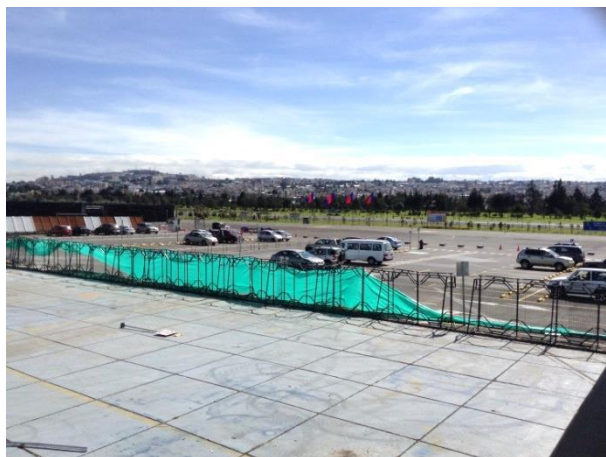
Figura 107. Fotografía del parqueadero posterior del lugar.
