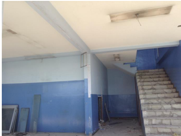
Figura 11. Ingreso a la edificación.
