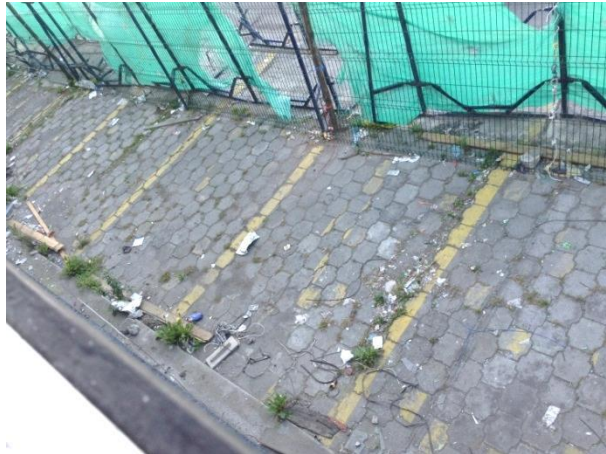
Figura 106. Fotografía del parqueadero frontal del lugar.
