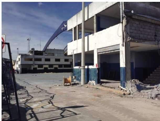
Figura 9. Vista lateral derecha de las oficinas.
