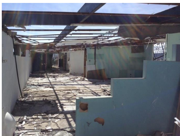
Figura 20. Vista interior del espacio en el tercer piso.
