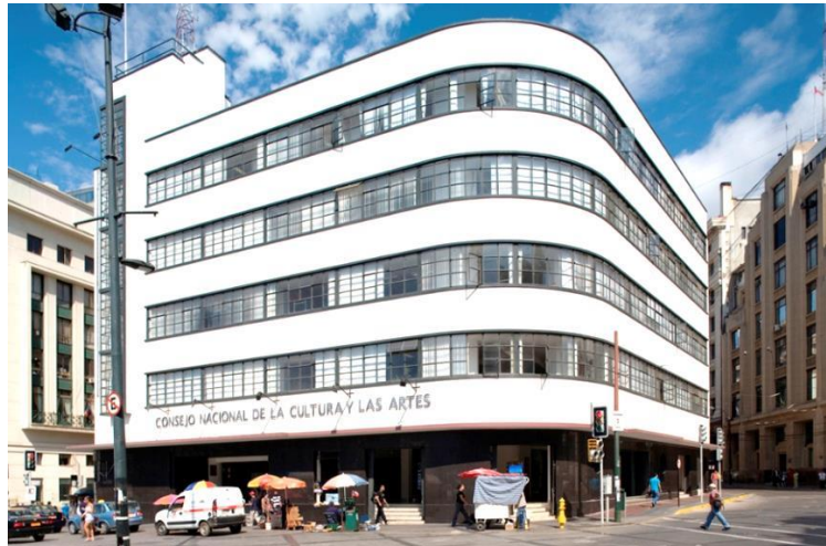
Figura 87. Fotografía de la edificación.
