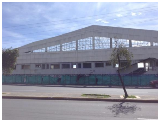
Figura 2. Vista del galpón y oficinas desde la Avenida Amazonas.
