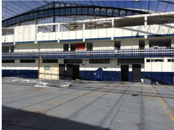
Figura 7. Oficinas abandonadas al fondo del galpón.
