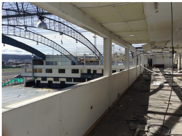
Figura 19. Vista desde el tercer piso hacia la parte izquierda.
