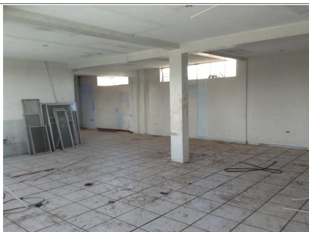
Figura 15. Espacios interiores de la edificación.
