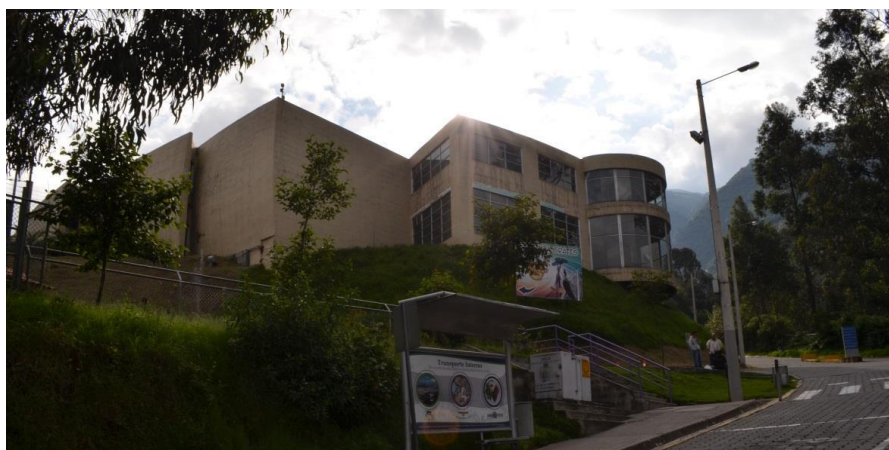
Figura 106. Ubicación del sol sobre el edificio, aproximadamente a las 4:45 pm.
