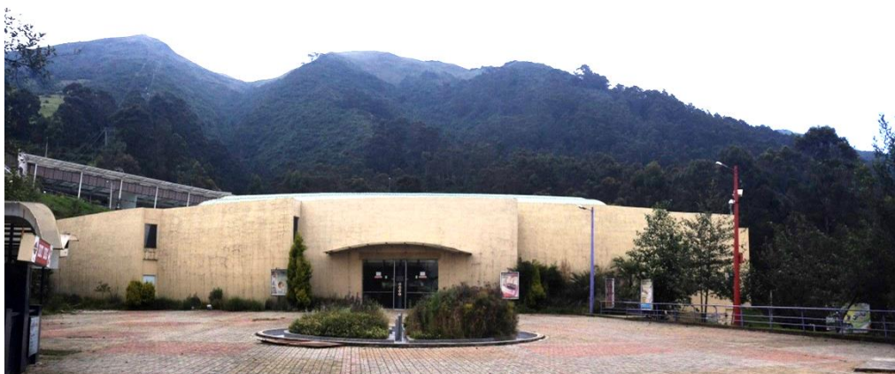
Figura 87. Fachada principal del centro comercial.
