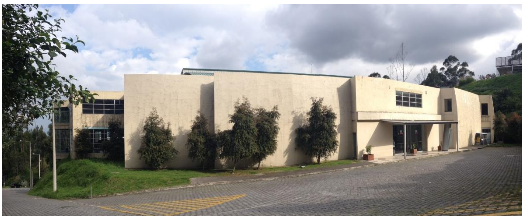
Figura 88. Fachada posterior del centro comercial.
