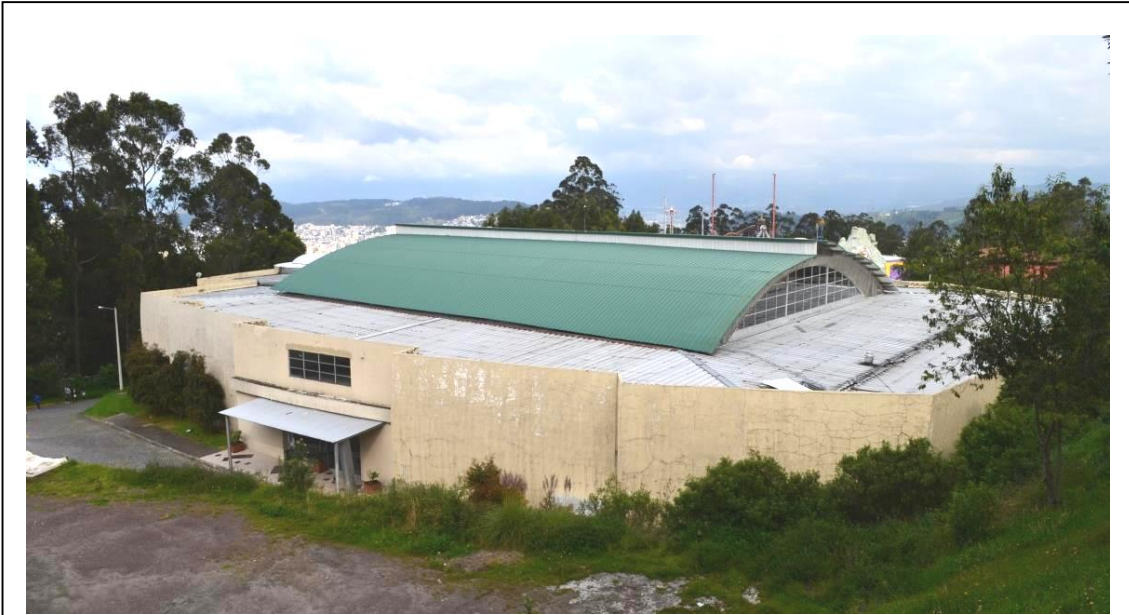
Figura 4. Cubierta del centro comercial del Teleférico.
