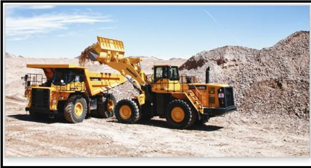
Figura 49. Paso 1 provisión de Insumos Hormigón
