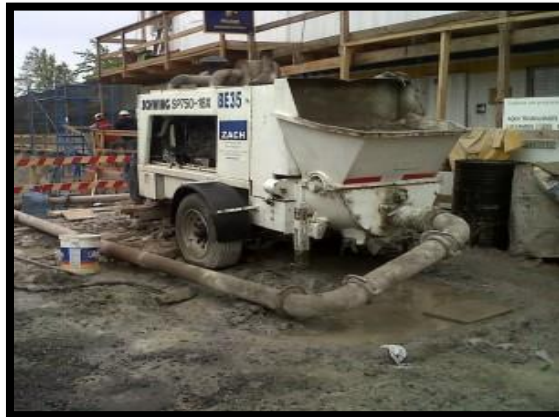
Figura 57. Paso 9 Bombeo del hormigón
