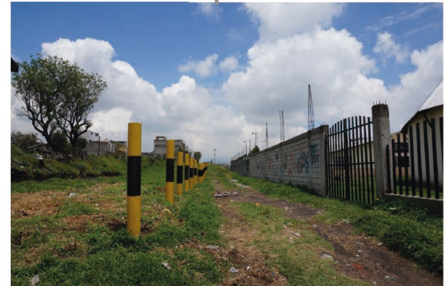
Eje de protección sobre poliducto junto a Casa comunal perteneciente a Iglesia de Sto. Tomás I
