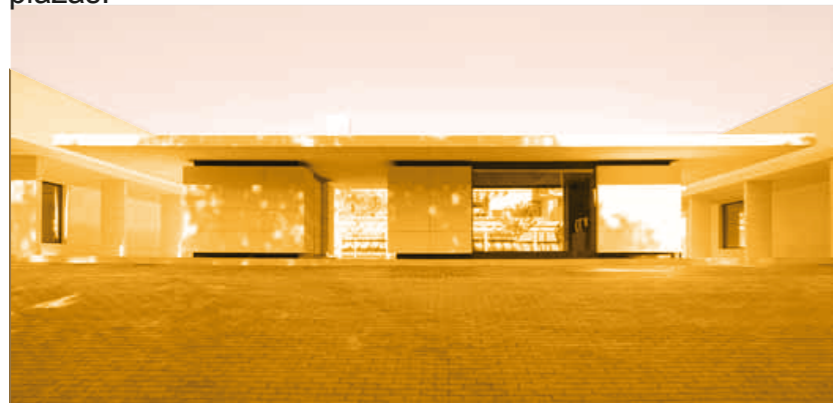
Figura 113. Acceso general al proyecto Adaptado de página web: Plataforma arquitectura
