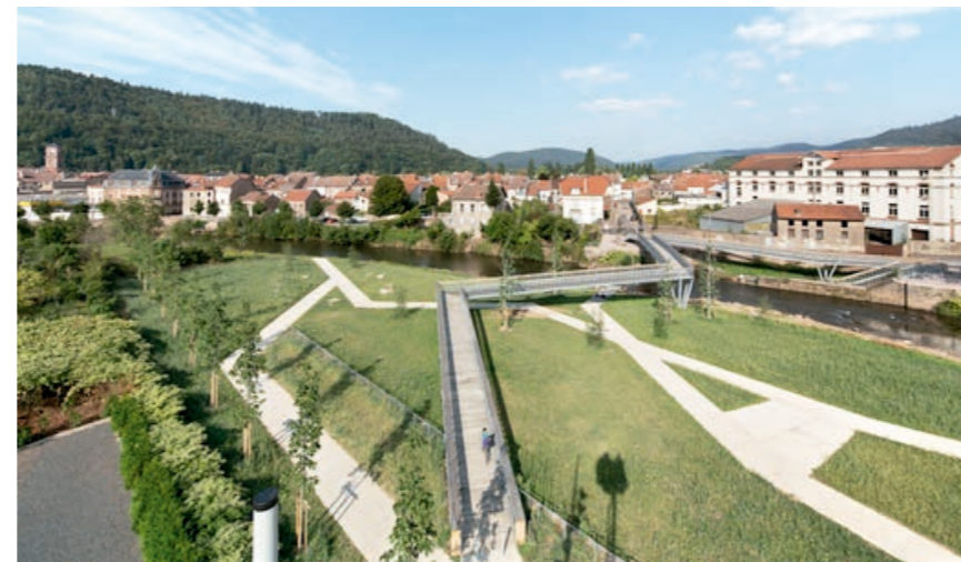
Figura 63. Conectividad en puente peatonal Tomado de Plataforma Arquitectura, S.F.
