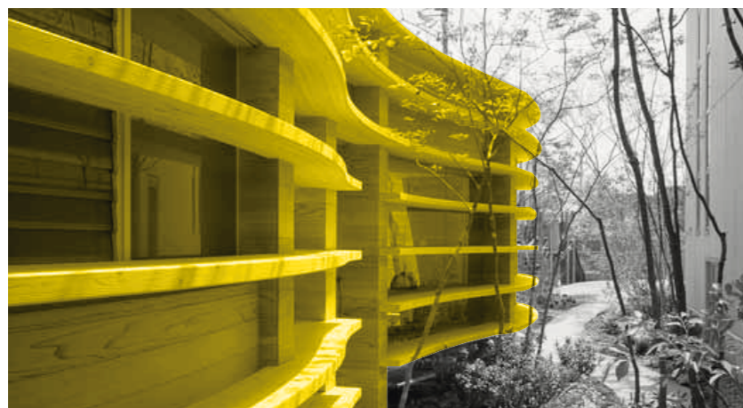
Figura 78. Fachada principal del proyecto Adaptado de página web: Plataforma Arquitectura
