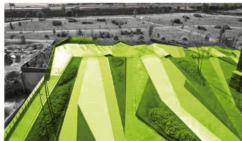
Figura 56. Vista aérea de la plaza hacia vía principal Adaptado de página web: Plataforma Arquitectura
