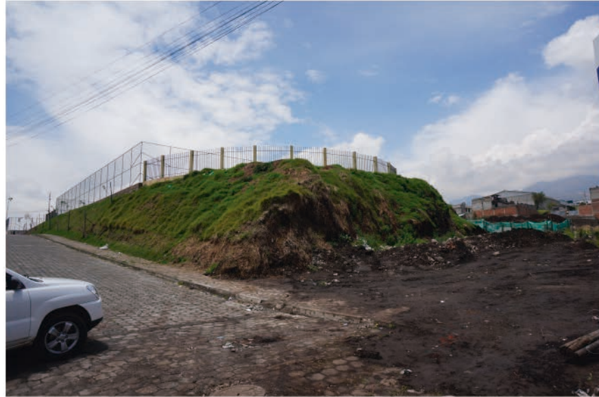
Vista hacia relleno realizado para nivelación del terreno
