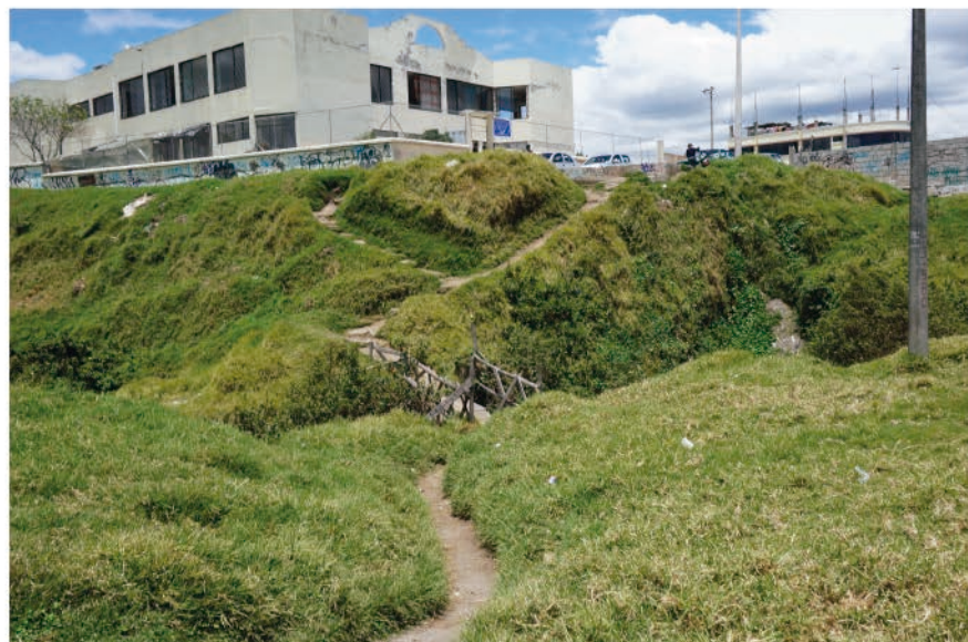
Quebrada de Caupicho y paso peatonal desde barrio Sto. Tomás hacia barrio San Juan de Guamaní
