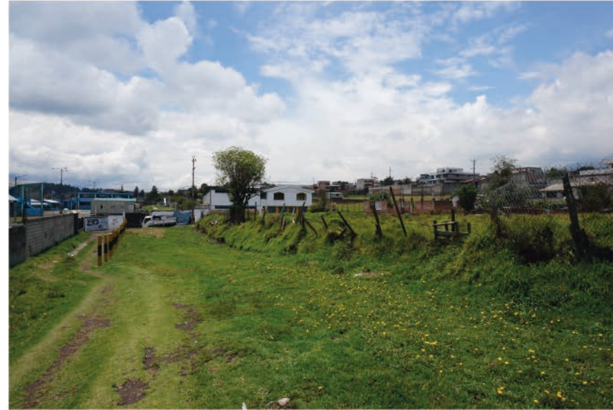
Eje de protección sobre poliducto junto a Escuela Valencia Herrera
