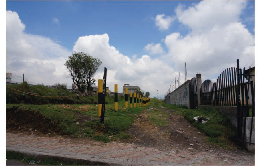
Eje de protección sobre poliducto junto a Iglesia Sto. Tomás I
