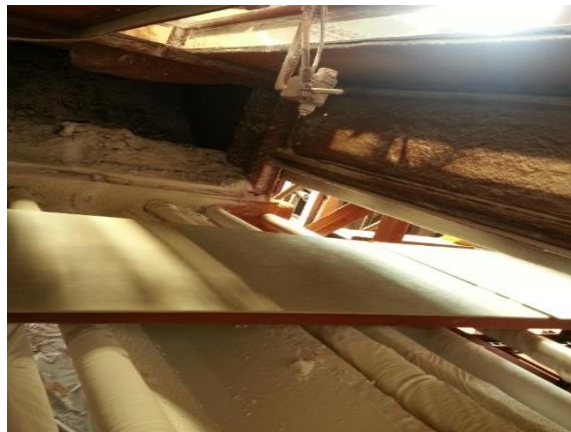
Figura 36. Pintura desperdiciada en tolva
