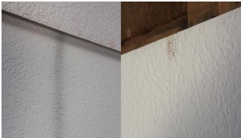
Figura 63. Ejemplos de Placa Manchada
