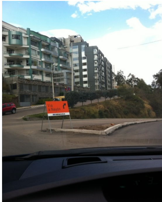
Figura 5. Fachada Lateral de la edificación
