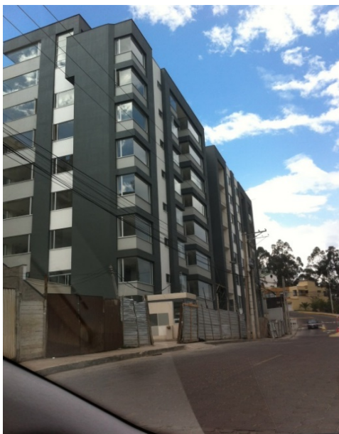
Figura 66. Localización de la Edificación, Fachada Lateral
