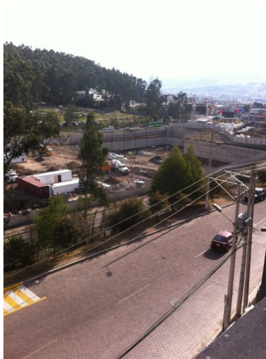
Figura 6. Vista desde la edificación al proyecto de oficinas Eco Park
