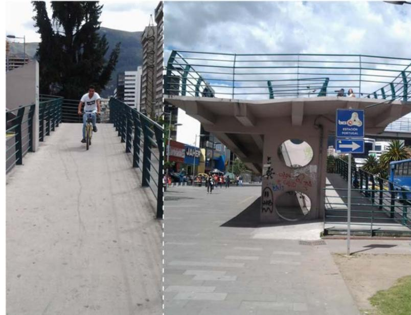
Figura 43. Eliminación de barreras arquitectónicas mediante rampas en avenida Naciones Unidas.
