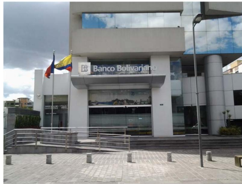
Figura 44. Solución de barreras arquitectónicas por medio de rampa lateral del Banco Bolivariano en la Naciones Unidas, Quito.
