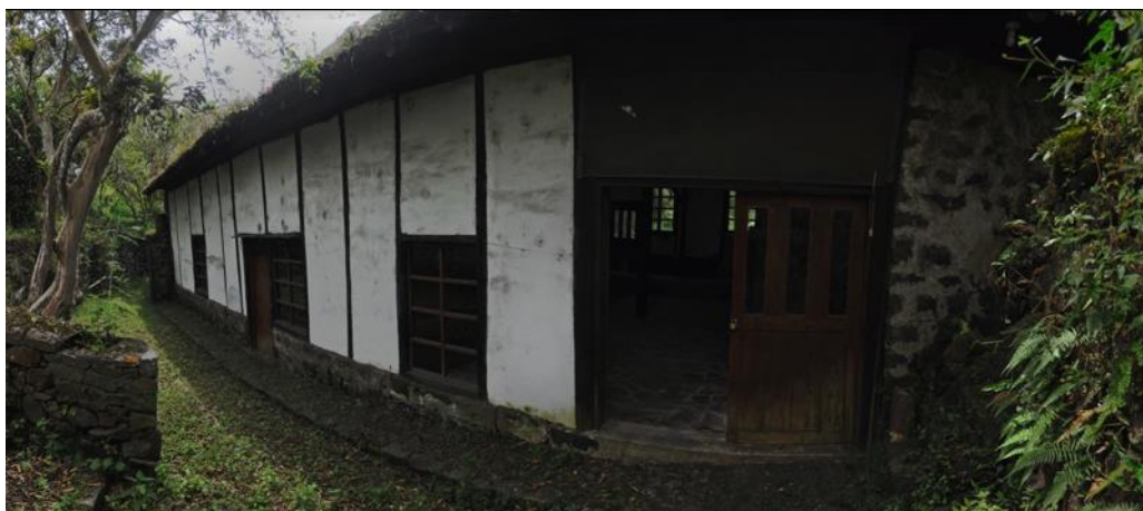
Figura 3. Área de ingreso al trapiche
