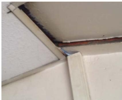
*Figura 39:* Muestra el cableado horizontal extendiéndose por el techo falso y bajando por canaletas plásticas
