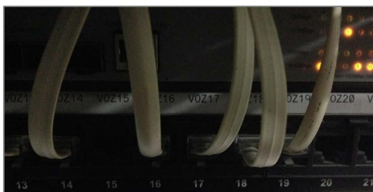
Figura 63: Distribución desde el patchpanel hacia los distintos puntos de voz.
