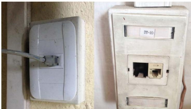
*Figura 40:* Puntos de red sin etiquetado
