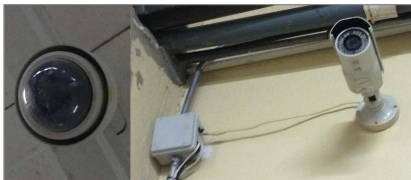
*Figura 42: Cámaras de circuito cerrado de tv. Cámara 360° (izq.) y cámara estática (der.)*
