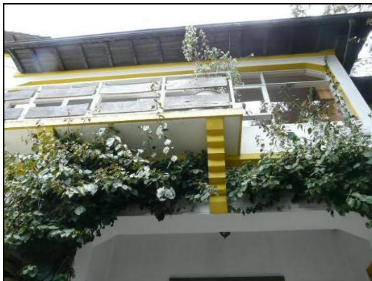
Foto P12: Fachada del hostal.
