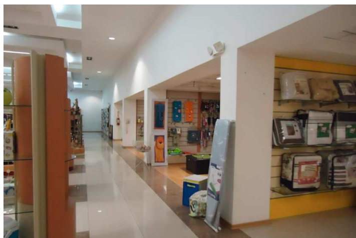
Figura 52. Estructura interior en el galpón
