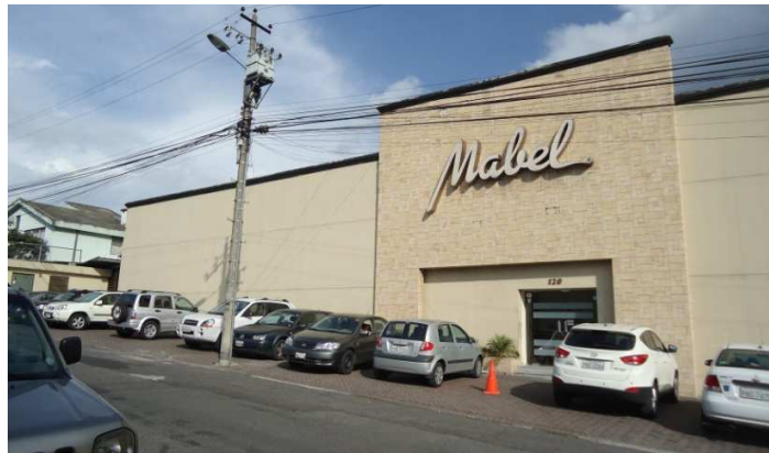
Figura 50. Ingreso principal a la edificación
