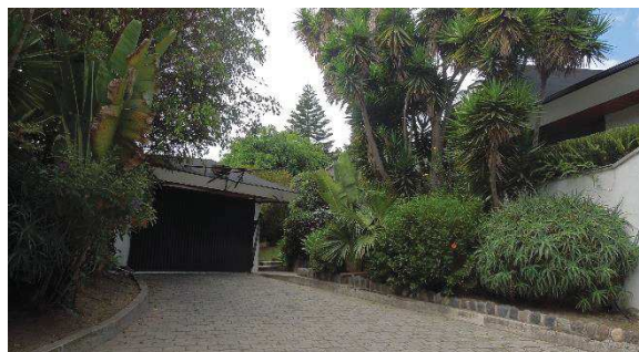
Figura 24. Puerta ingreso parqueadero
