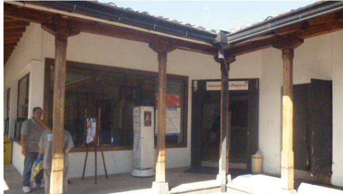
Figura 52: fachada frontal área de recaudación
