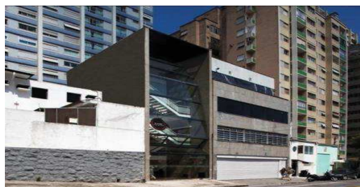
Figura 8, Fachada Frontal Tomado de (Plat. Arquitectura S.F)
