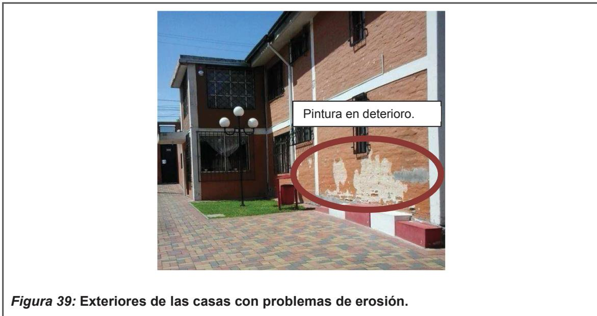
La pintura exterior de las casas sufren un gran deterioro, tienen problemas de erosión, debido a que la estructura de ladrillo no ha tenido un tratamiento previo al ser pintado, como consecuencia, la pintura después de un tiempo se descascara y se cae por el maltrato del clima.
