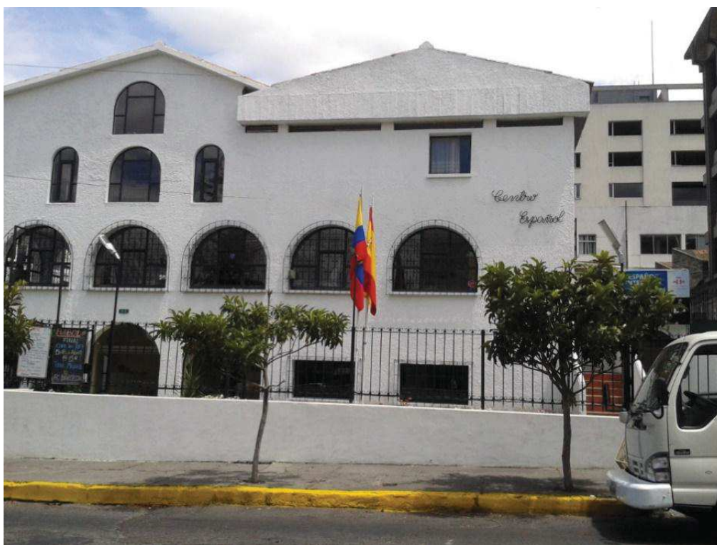
Figura 73 Fachada frontal Centro Español.
