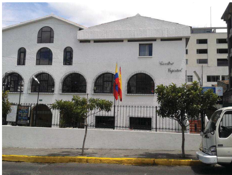
Figura 5 Vista fachada frontal.
