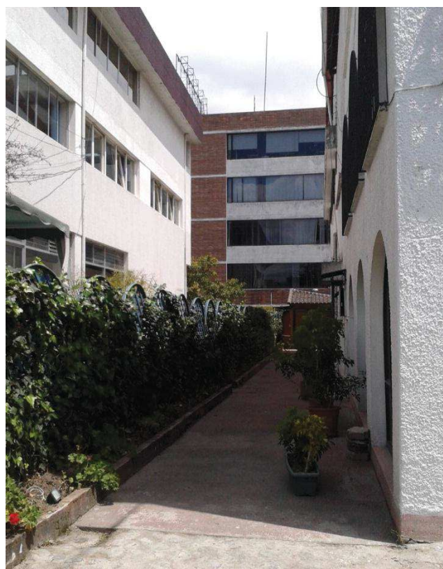
Figura 16 Vista acceso patio posterior.
