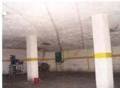
La construcción cuenta con una estructura de hormigón armado, con un sistema de columnas y vigas, con una luz máxima entre columna y columna de 5.30 m, las dimensiones de cada columna es de 40 x 40 cm.
