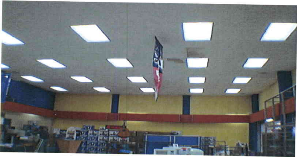
Fotografía 5 DETALLE DEL CIELO RASO
