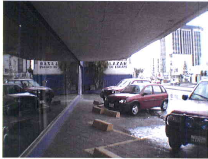
Fotografía 9 ALEROS DE LA EDIFICACION
