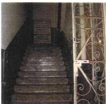
Escaleras de hormigón
