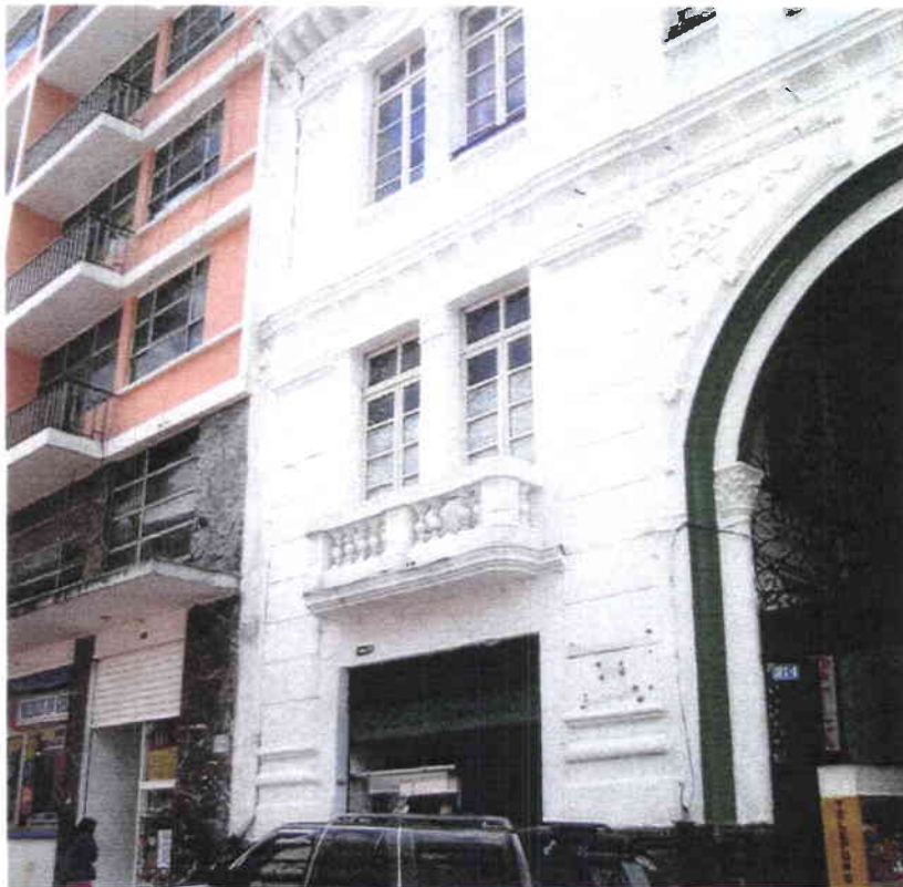
Extremo izquierdo de la fachada que da a la Calle Sucre
