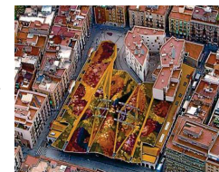
Figura 216. Estructura cubierta Tomado de (mercado central el 15 de sep del 2014) http://www.elperiodico.com/
