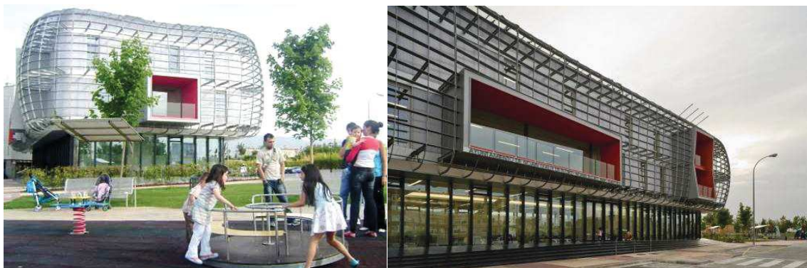
Imagen N°25: Ayuntamiento de Noáin.
