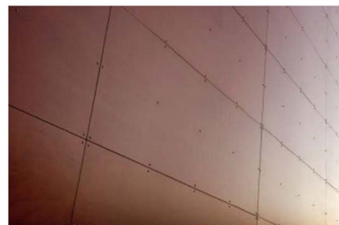
El Alucobond es un sistema de fachadas u cerramientos exteriores que consiste en un sistema de triple hoja, la interior es la que resiste las cargas de viento y horizontales a los forjados, la intermedia ayuda al aislamiento térmico, y la exterior que obrará de paraguas a la lluvia, puesto que está separado dejando una cámara de aire que a demás es ventilada para la evaporación.
