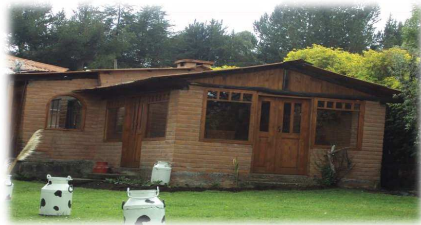
Figura No. 8 Exterior comedor restaurante
