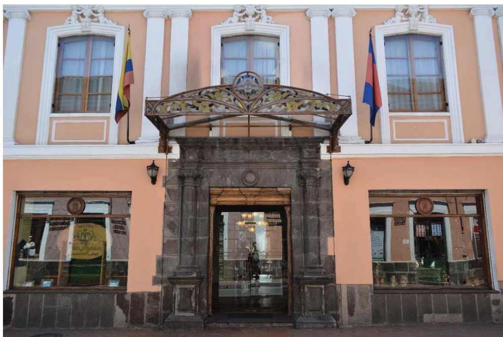
Figura 42. Hotel Plaza Andaluz
