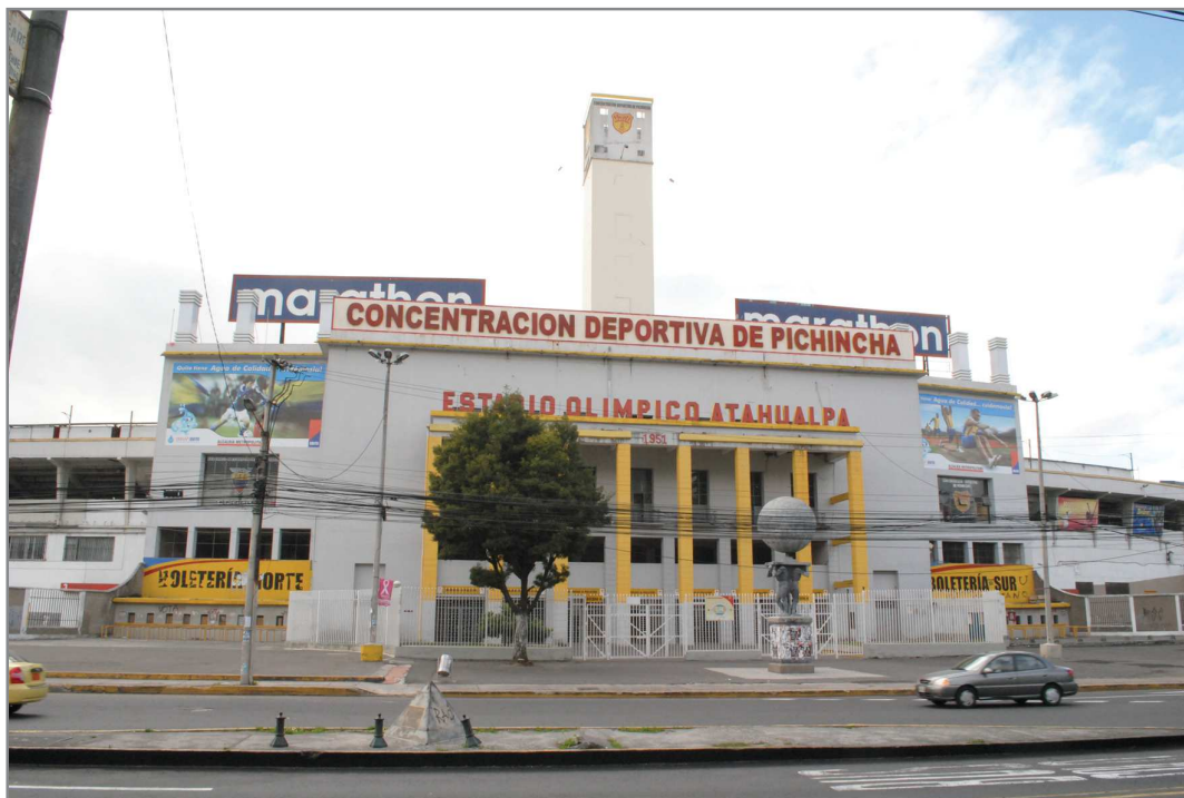
Figura. 87. Estadio Olímpico Atahualpa, fachada frontal. Fotografía, David Pavón.
