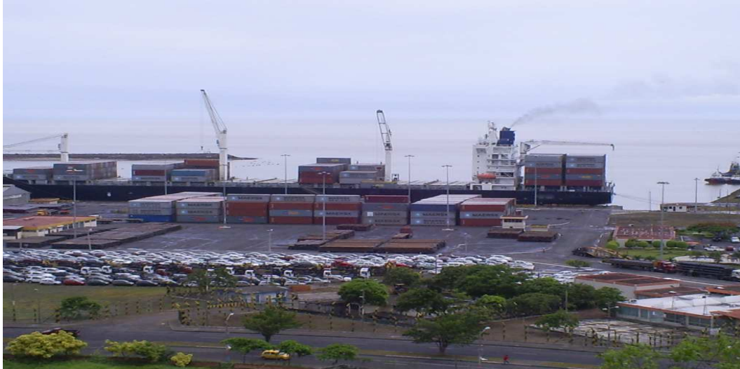
Muelle No.2 y No.1 (Ro-Ro)
