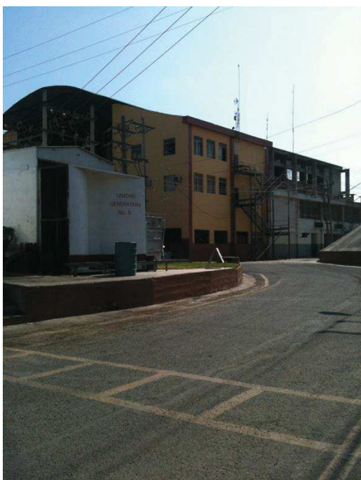
Ingreso a Planta
