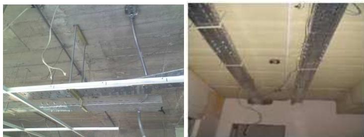
Ilustración 92 - Tendido de Ductería
