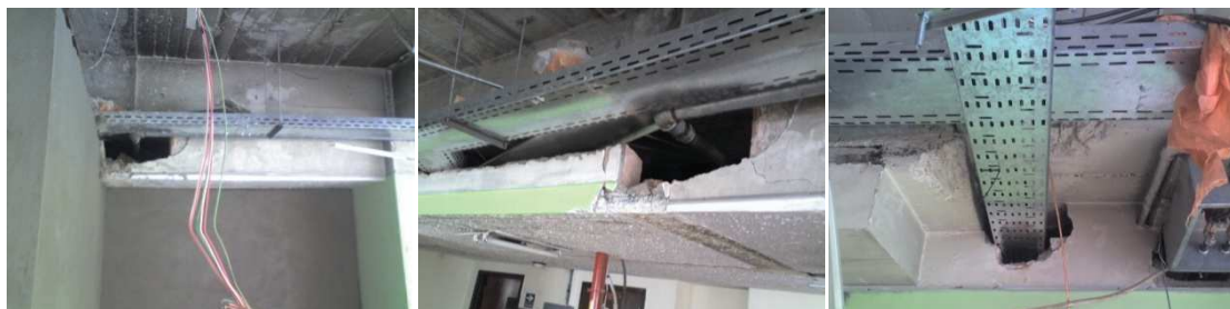
Ilustración 93 - Paso de Ductería a través de columnas
