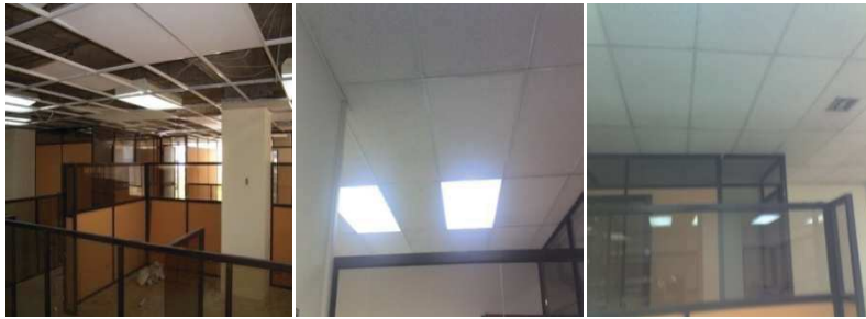
Ilustración 102 - Techo Falso finalizado
