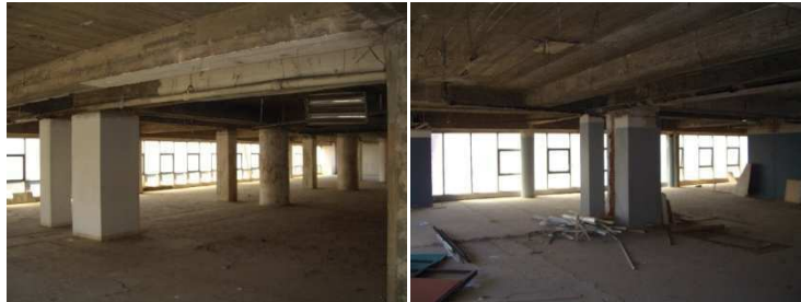
Ilustración 90 - Infraestructura inicial del proyecto área de equipos
