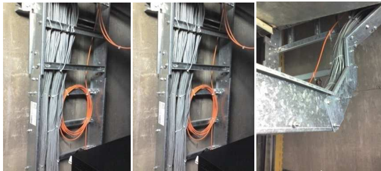
Ilustración 96 – Tendido de cable vertical por Ductería
