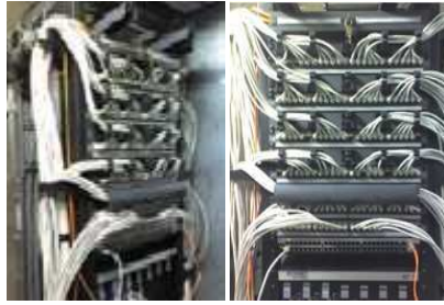
Ilustración 106 - Tendido de cable en los racks
