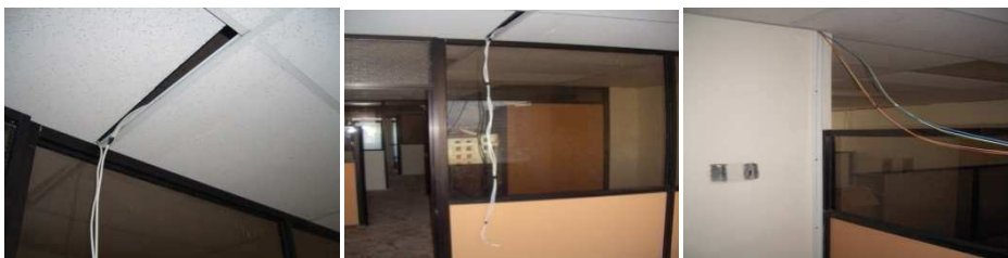
Ilustración 97 - Tendido pasando por techo falso
