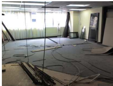
Ilustración 91 - Infraestructura inicial del proyecto área administrativa
