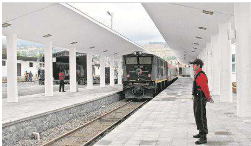
Figura 69. Estación de Ambato
