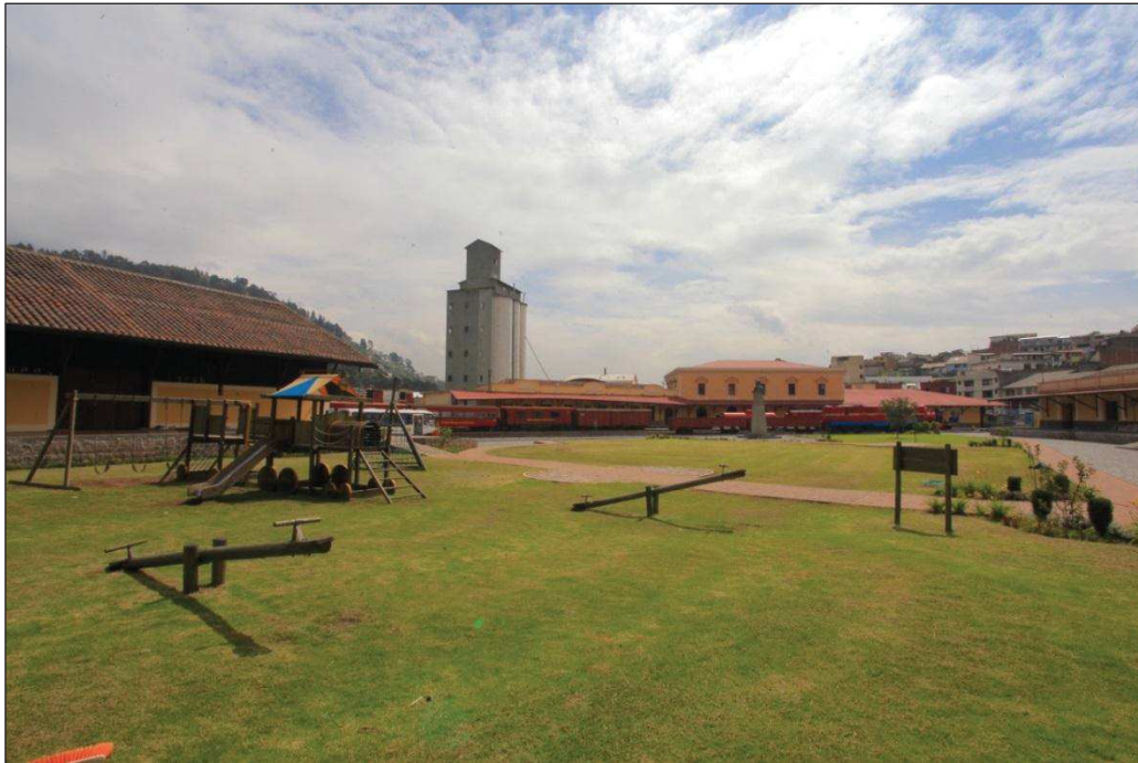
Figura 178. Estación de Chimbacalle
