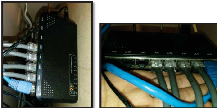
Figura 52: Conexión de los cables en el *Switch* capa 2.
