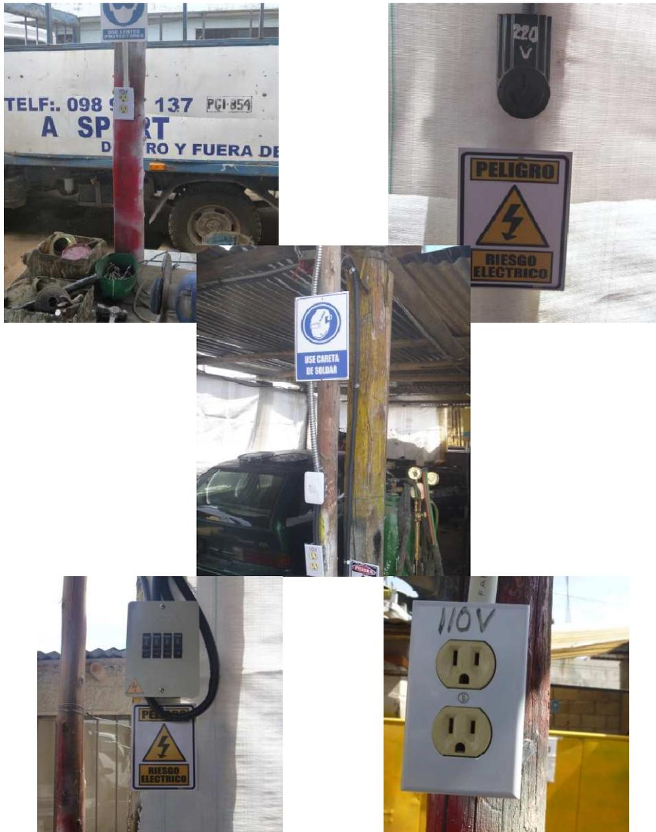
Figura.23. Señalización según el plan Mínimo de Prevención de Riesgos del Taller y norma INEN.
