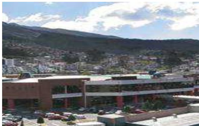
FIGURA 7. Vista panorámica externa
