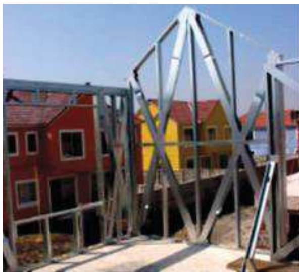
Figura 4. Vivienda construida con perfiles metálicos livianos Tomada de (Hunter Douglas, p.8)
