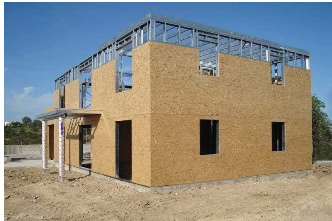
Figura 11. Aplicación del tablero OSB en Exteriores.
