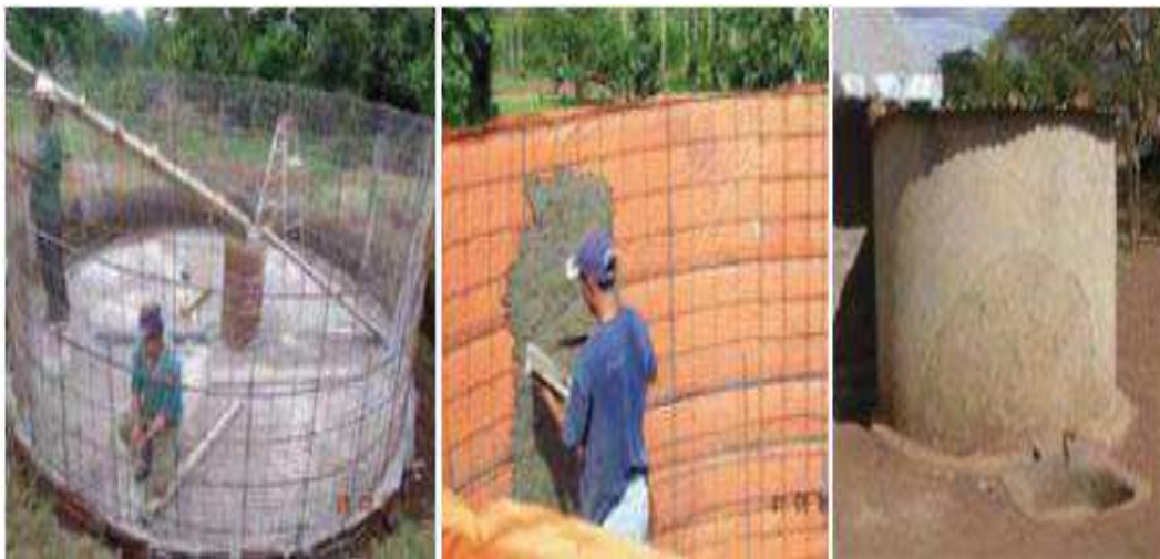
Figura 15: Cisterna de ferrocemento
