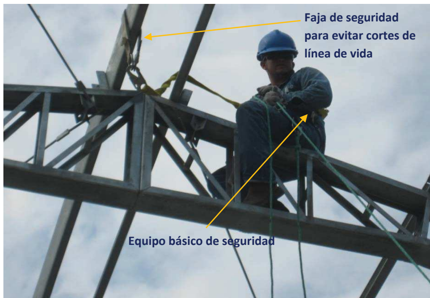
Figura 74. Equipo de seguridad trabajo en alturas.
