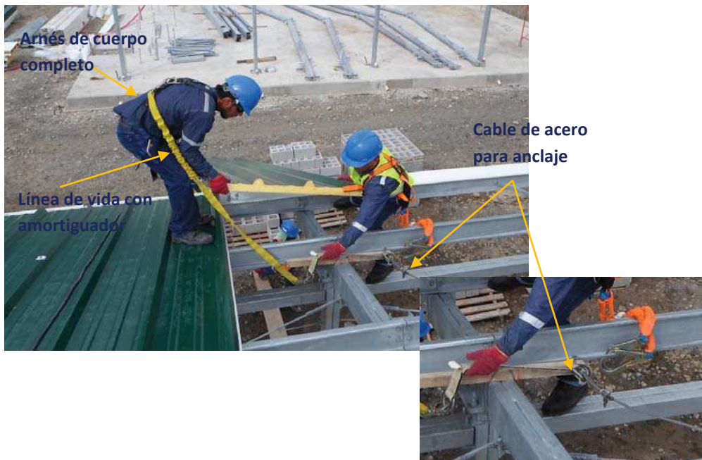
Figura 75. Equipo de seguridad trabajo en alturas.
