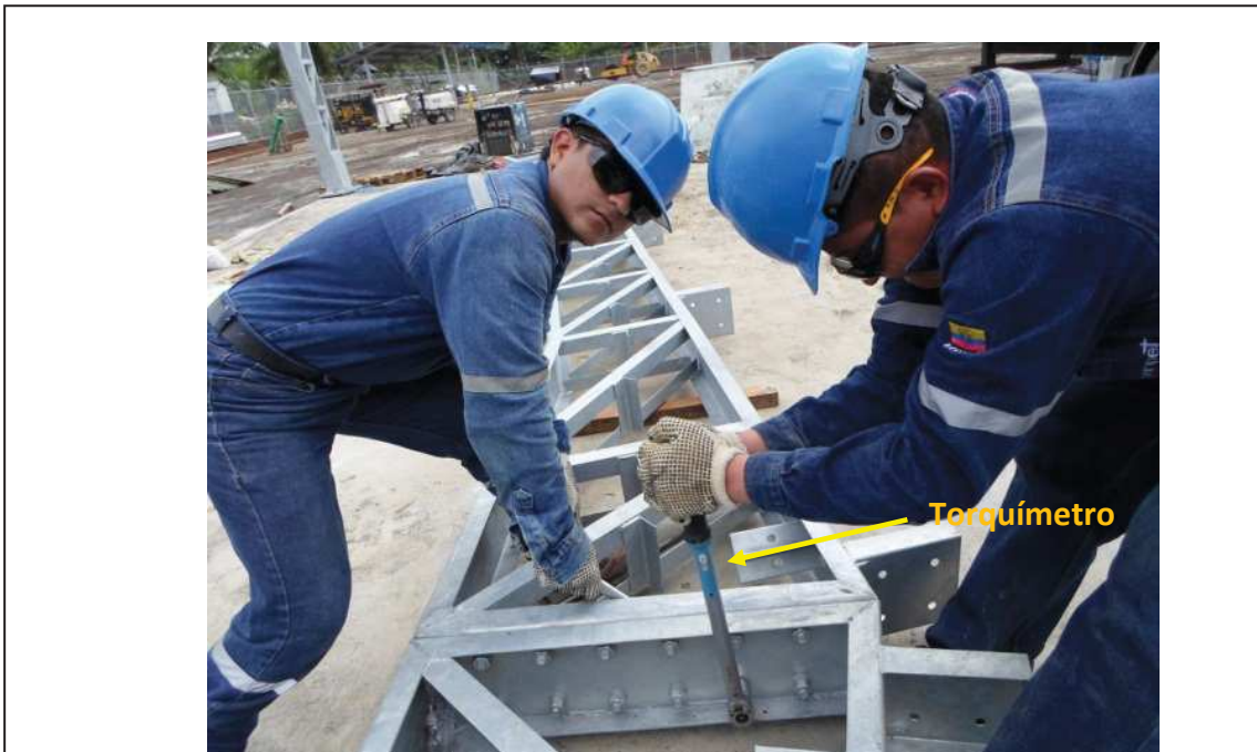
Figura 72. Torque de pernos.
