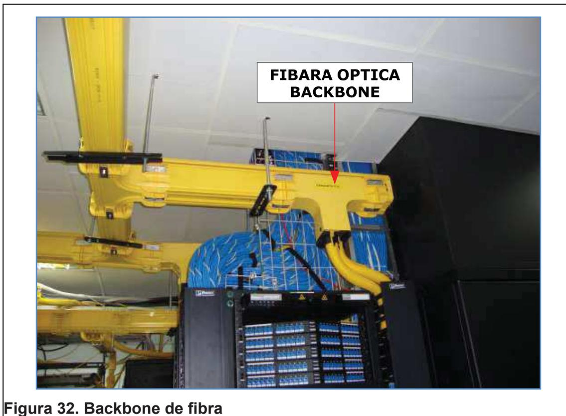
Para este tipo de conexiones se usa principalmente fibra óptica Multimodo cuando las distancias no son muy grandes hasta 300 m en el caso de fibra óptica OM3, por su gran ancho de banda que puede proporcionar y las altas velocidades de transmisión que puede suministrar, en el caso de distancias grandes se usa fibra óptica Monomodo. En la siguiente figura, se puede ver
