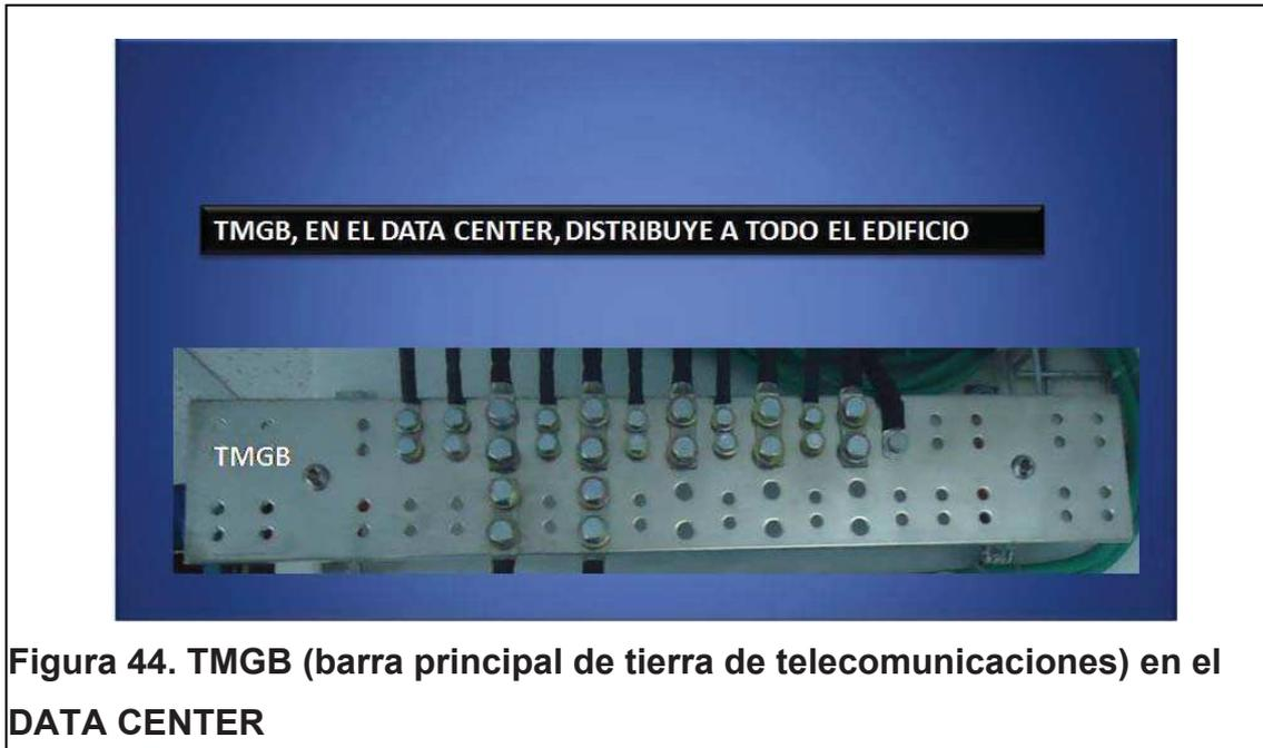
En la siguiente figura, se aprecia los cables y las conexiones de tierra en un sistema de telecomunicaciones.
