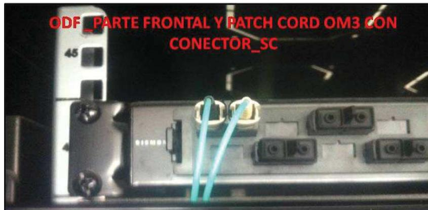
**Figura 38. ODF parte frontal con Patchcord OM3**
