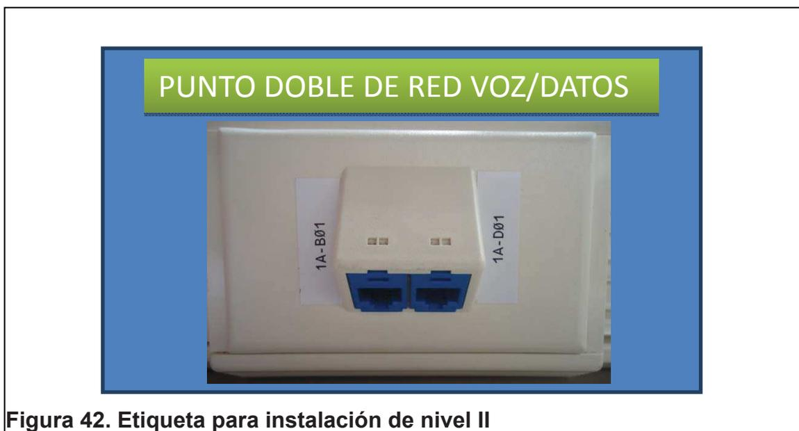
**Figura 42. Etiqueta para instalación de nivel II**
