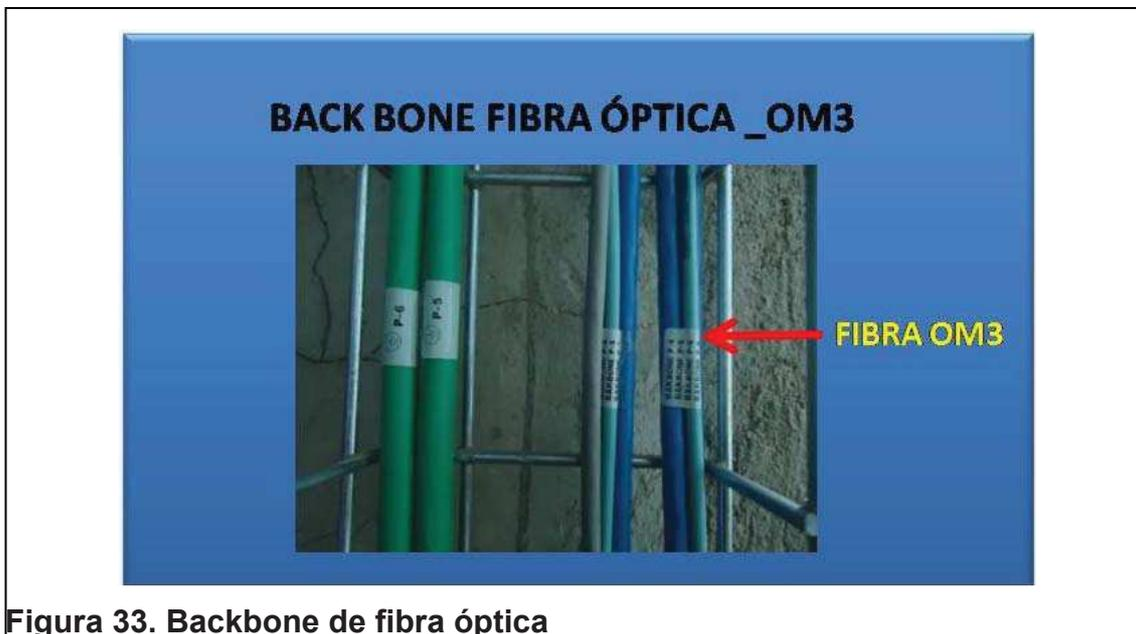
Figura 33. Backbone de fibra óptica
