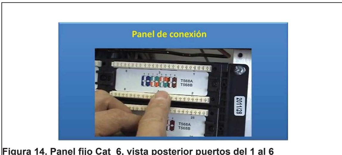
**Figura 14. Panel fijo Cat\_6, vista posterior puertos del 1 al 6**
