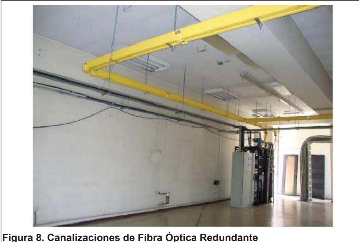
El radio de curvatura mínimo interior de las canalizaciones horizontales no pueden ser menor a diez veces el mayor diámetro de los cables a instalar, esto tiene como fin garantizar un buen desempeño del cable instalado en dicha bandeja, estas bandejas serán de fácil acceso para implementaciones futuras o cambios requeridos por situaciones de mantenimiento.
