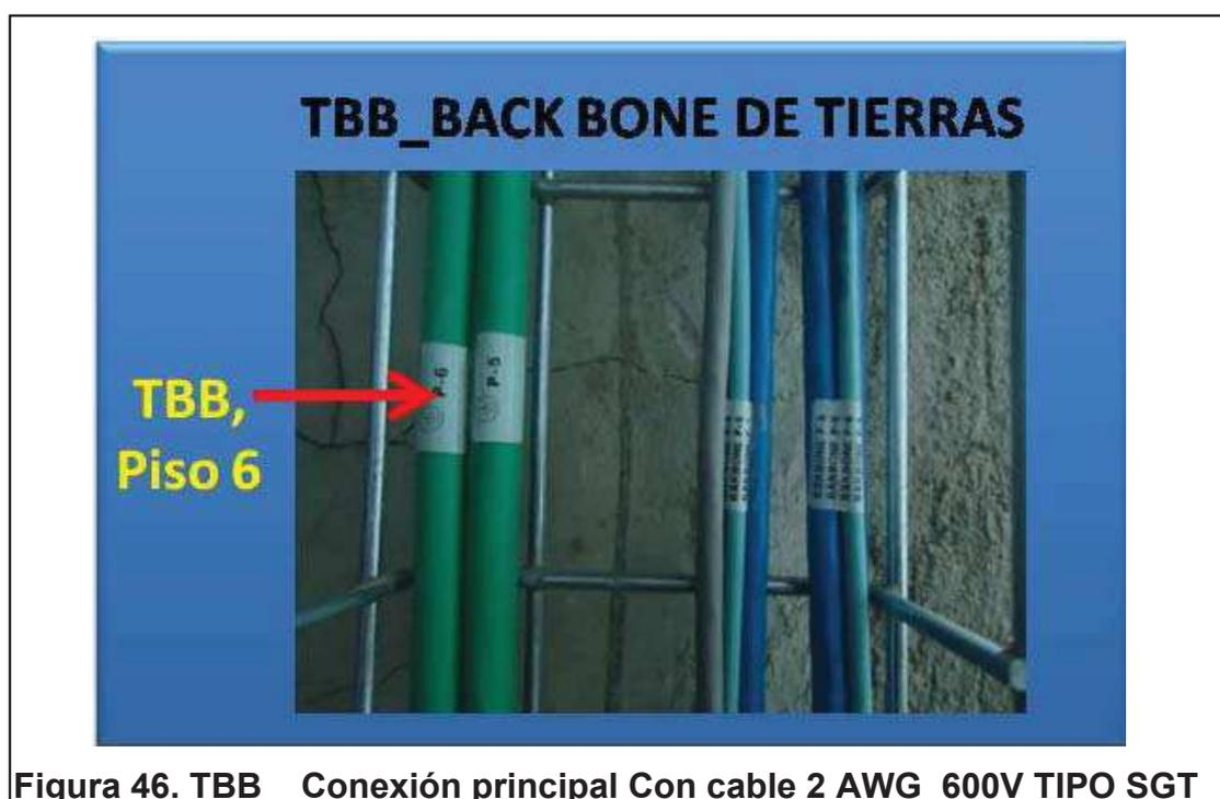
Figura 46. TBB \_ Conexión principal Con cable 2 AWG\_600V TIPO SGT
