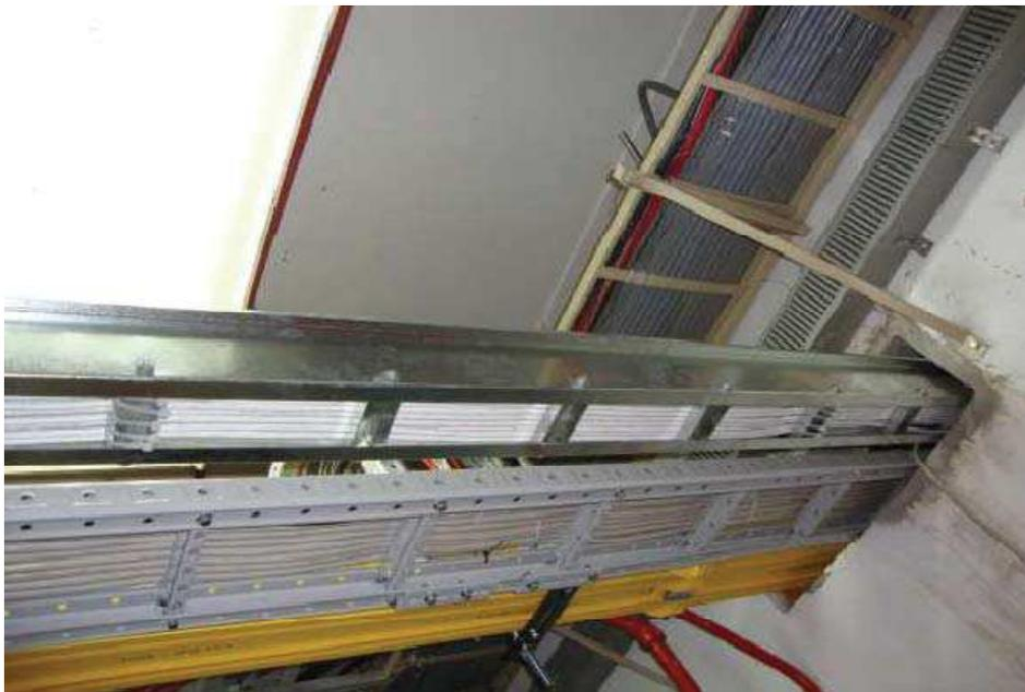
**Figura 13. Bandeja de fibra y cobre**
