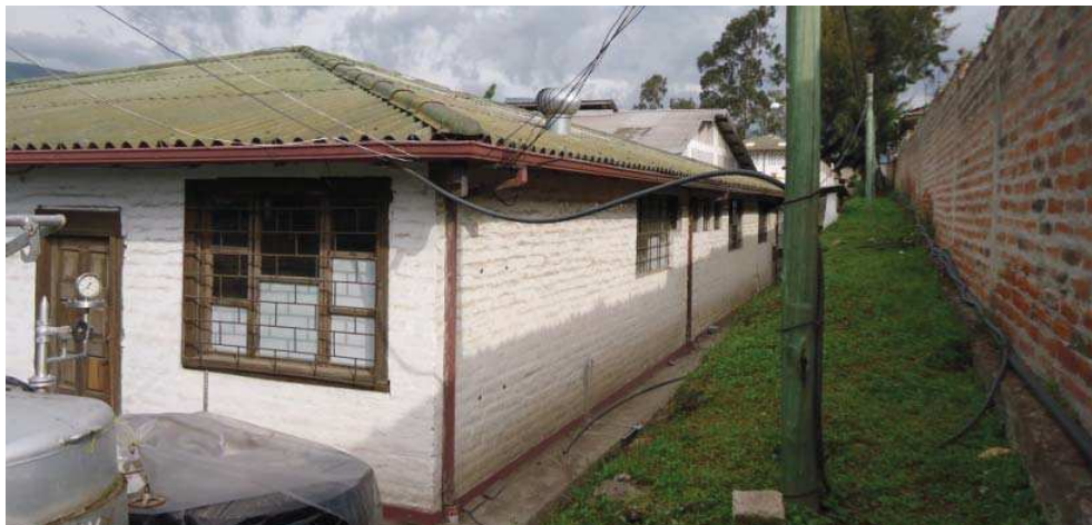
Figura 41. Cable aéreo saliente de Administración
