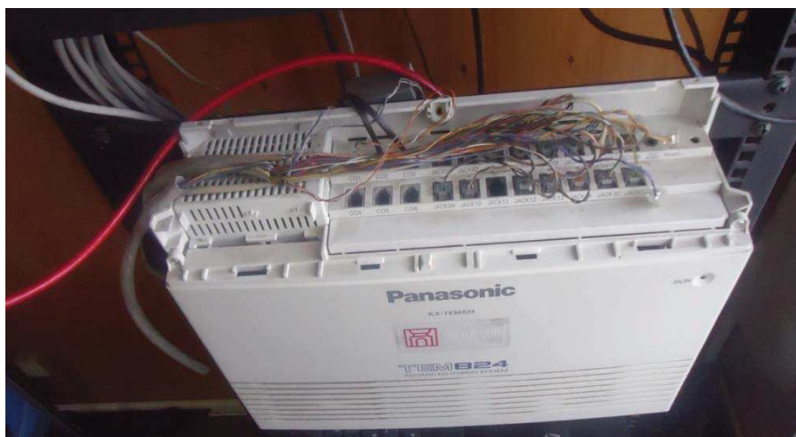
Figura 48. Central Telefónica TEM 824
