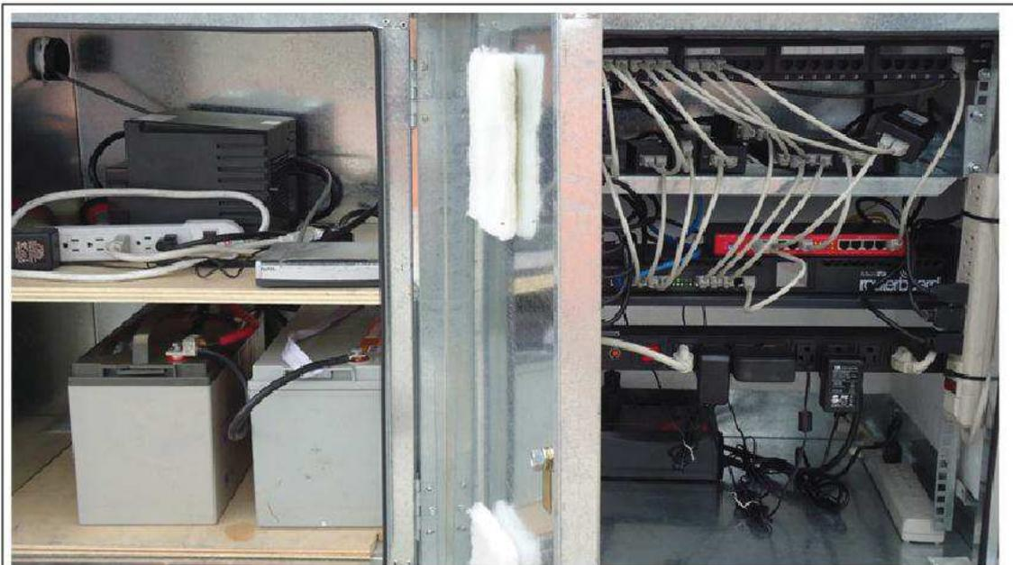
Figura 48. Imagen de las 2 cajas de intemperie debidamente conectados, cumpliendo con la norma ANSI/TIA/EIA 568 B.
