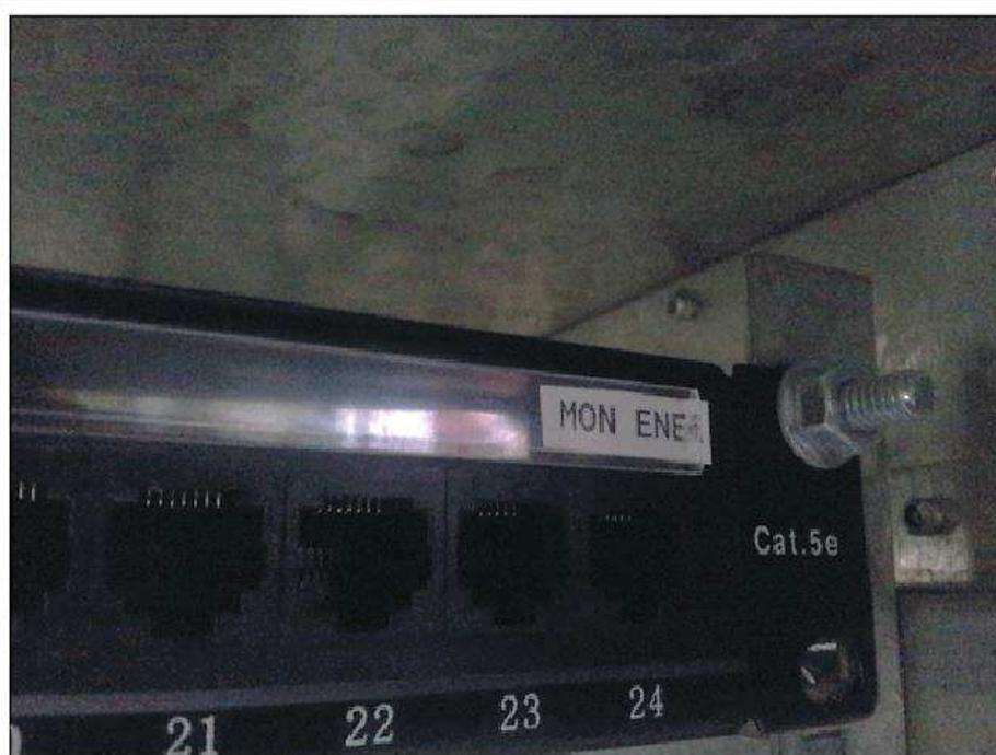
Figura 45. Patch panel etiquetado con el ultimo puerto perteneciente al monitoreo de energía.
