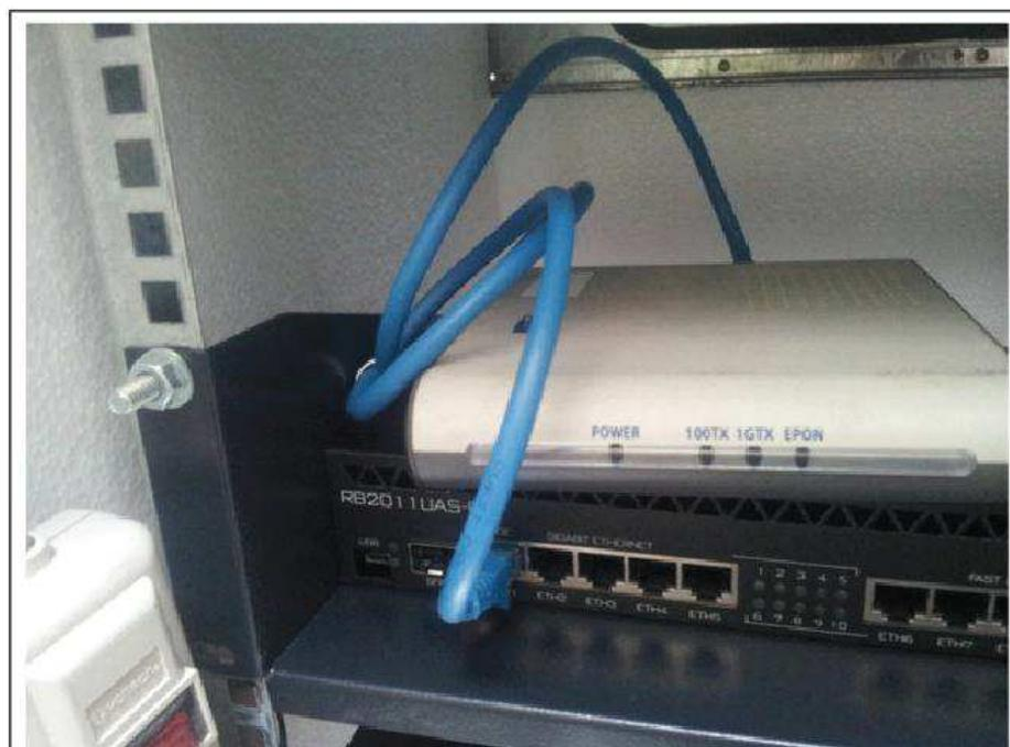
Figura 47. Conexión del ONT con el router principal por medio del patch cord UTP cat 6
