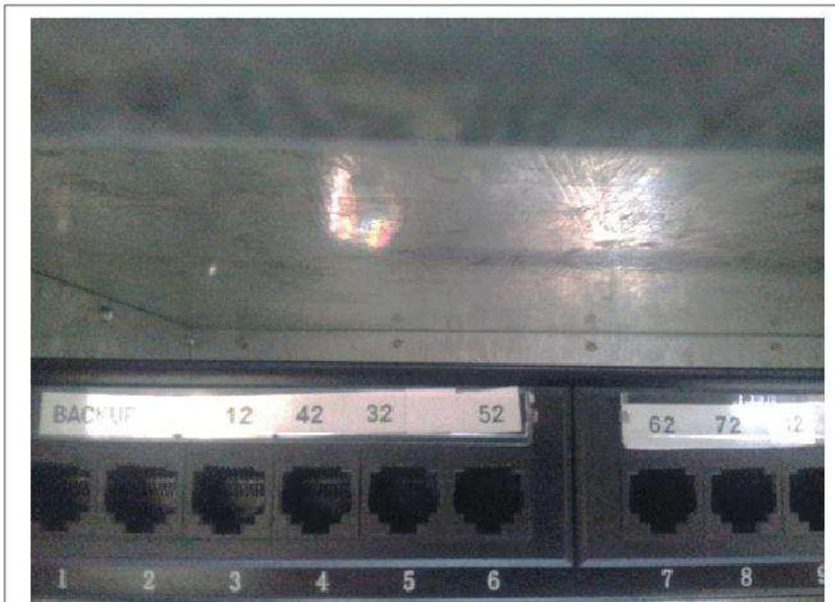
Figura 44. Patch panel etiquetado con los puntos de red de los equipos externos.
