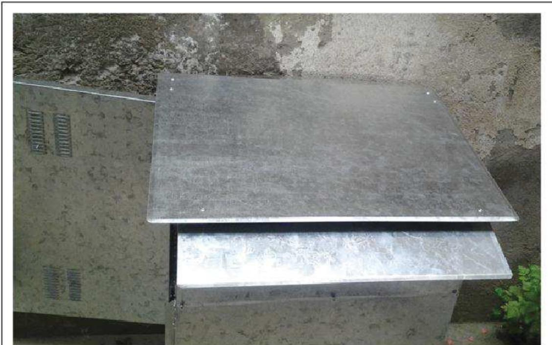
Figura 32. Caja de intemperie – Perfil superior
