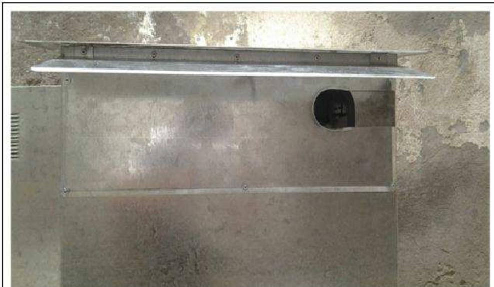
Figura 36. Entrada para permitir el acceso de los cables
