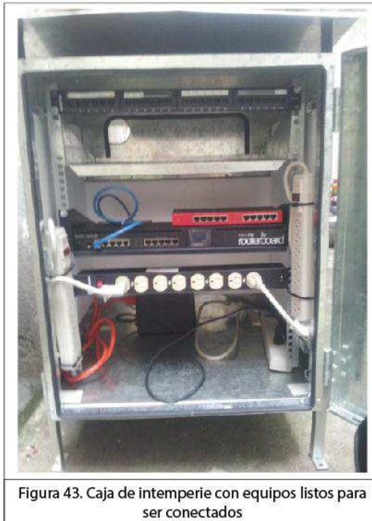
Figura 43. Caja de intemperie con equipos listos para ser conectados
