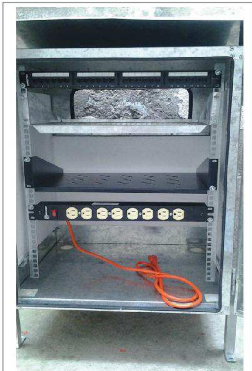
Figura 39. Caja de intemperie diseño interior incluido bandejas y multitomas.
