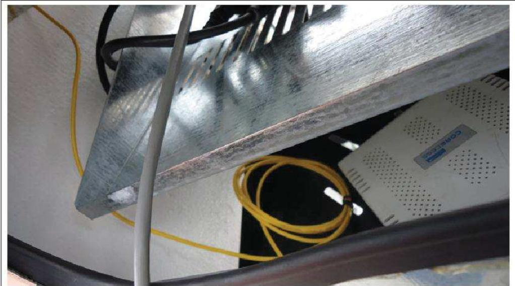
Figura 42. ONT conectado por medio del patch cord de fibra óptica que baja desde la bandeja de fibra.
