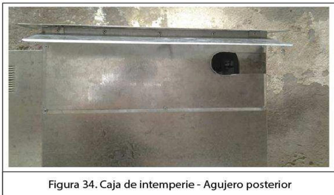
El agujero mencionado anteriormente por el cual se realizaran los trabajos de ponchado y todo repatch panel se lo puede apreciar en la figura 35 visto desde atrás de la caja, este agujero tiene una altura de 14.5 cm y 39 cm de ancho, además cuenta con una protección de caucho en su filo para evitar daño en los cables que van a ingresar y su vez proteger del agua al interior de la caja.
