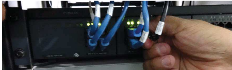
Figura 28. Conexión de troncales y extensiones analógicas
