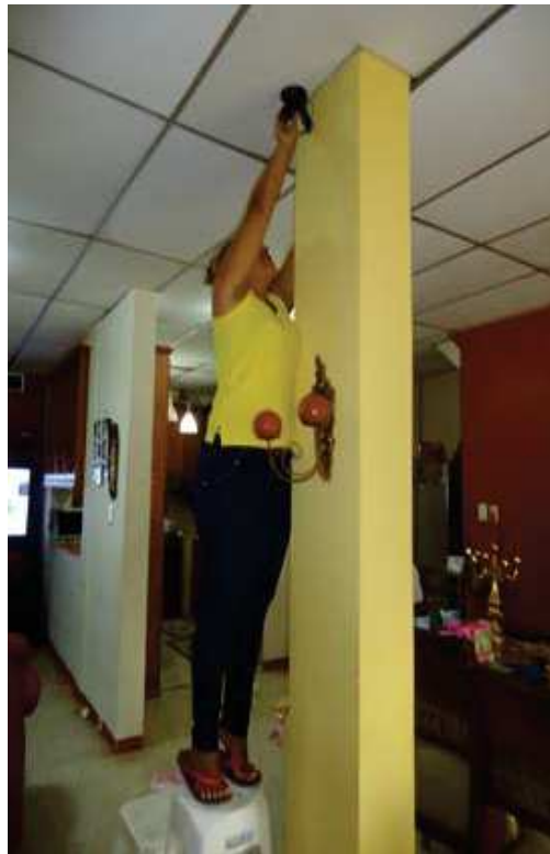
Fig. #56 Instalación Cámara
