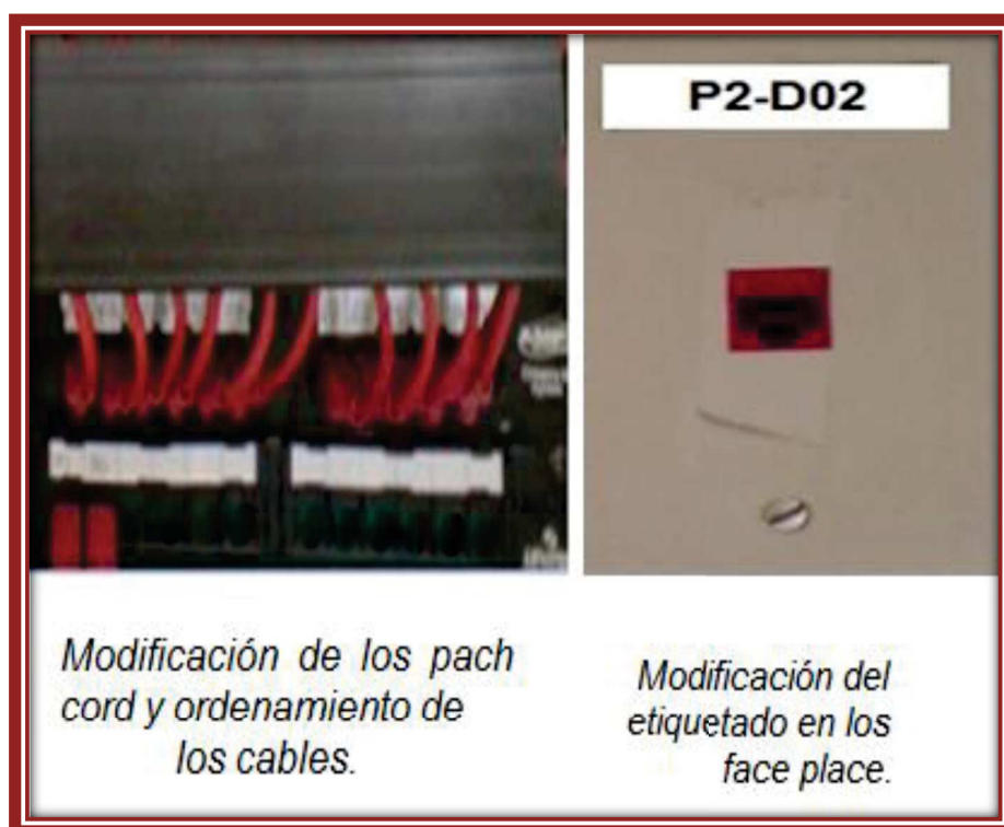
Fig. 4.12. Modificación de los cables y etiquetado de los cables.
