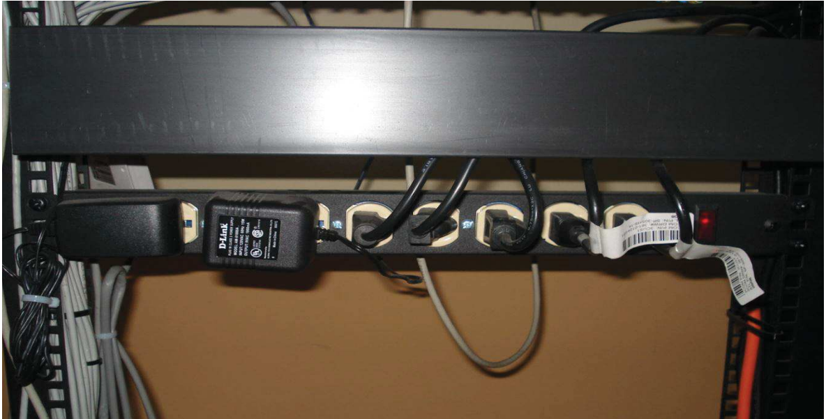
Anexo 10. Se colocó los organizadores dobles y multitoma eléctrico para la energización de los equipos en el cuarto de telecomunicaciones.
