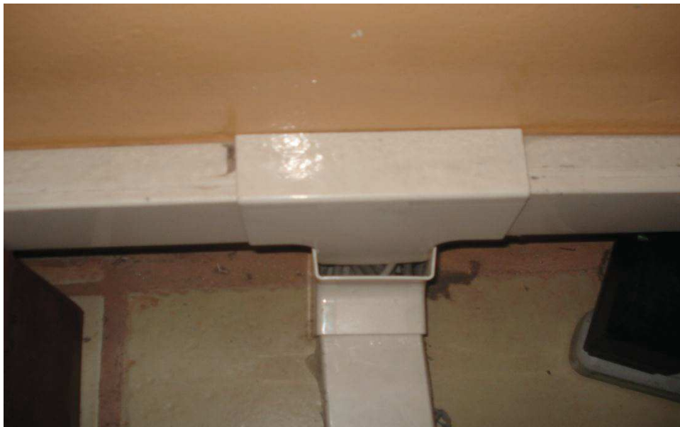
Anexo 5. Se instaló el recorrido del cableado con canaleta plástica.
