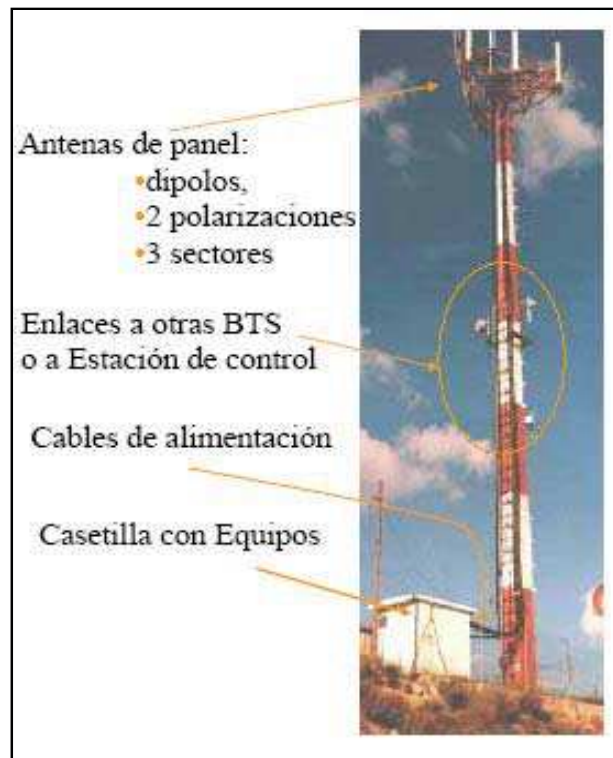
Figura 1.18 Torre de telecomunicaciones
