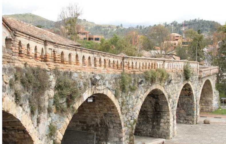
Figura 10. El Puente Roto
