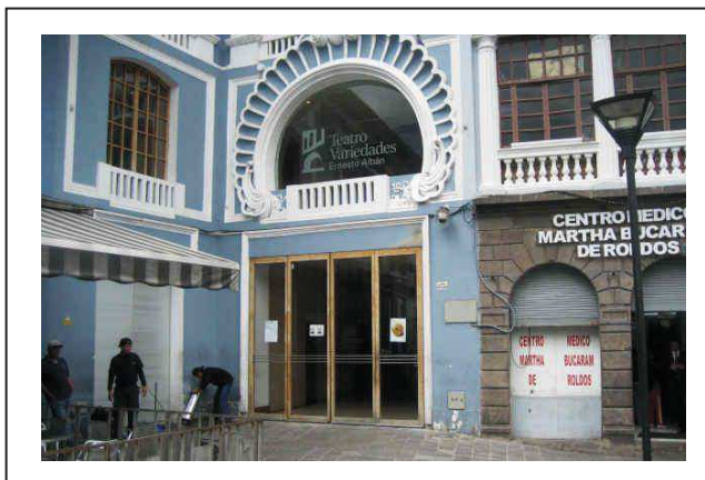
Figura 63. Fachada del Teatro Variedades. Tomado de (Live Well Ecuador, 2009)
