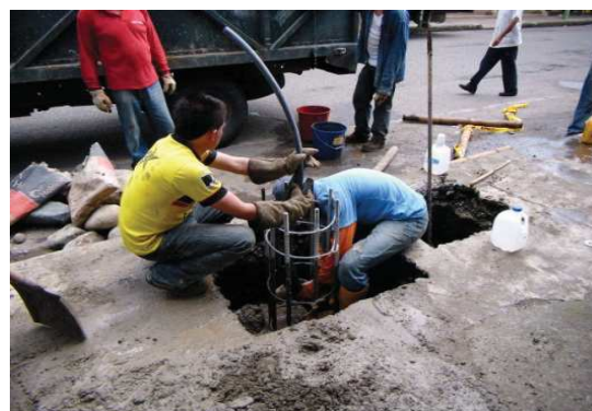
Figura 9. Proceso de fundición del plinto.
