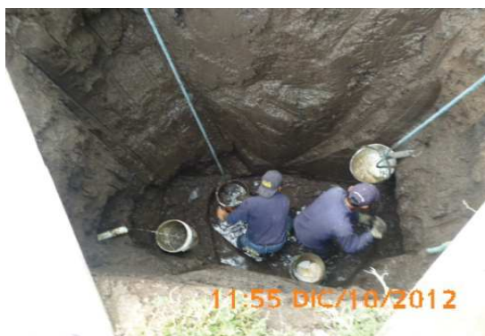
Figura 8. Proceso de perforación del hueco para la fundición del plinto.
