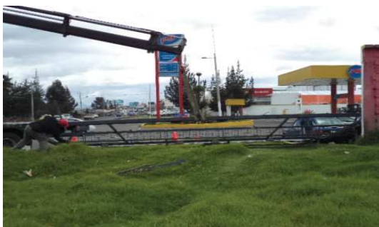
Figura 10. Proceso de ensamblaje de los marcos.
