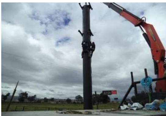
Figura 12. Proceso de ensamble de parante.
