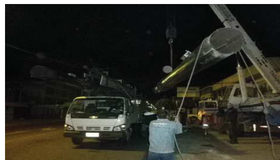
Figura 11. Proceso de izaje de los marcos
