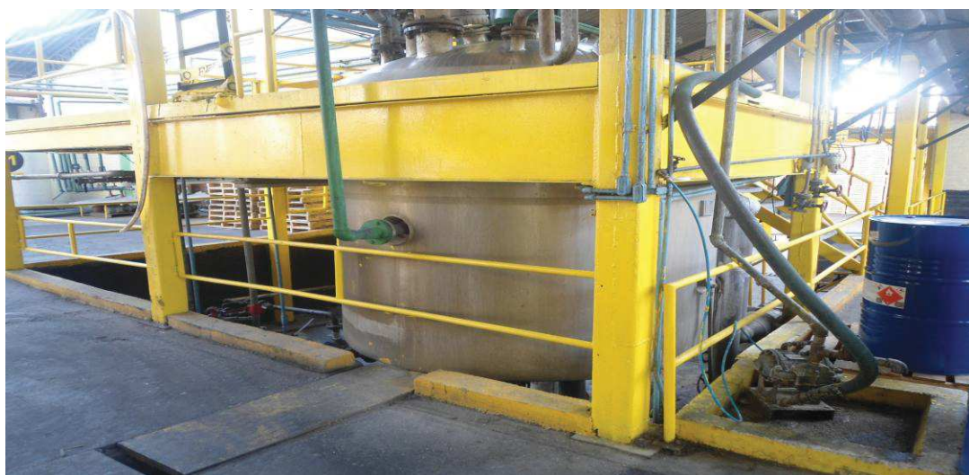
FIGURA 3. AREA DESDE DONDE SE BOMBEA EL AGUA DE LOS ISOTANQUES A LOS REACTORES. PINTURAS CONDOR
