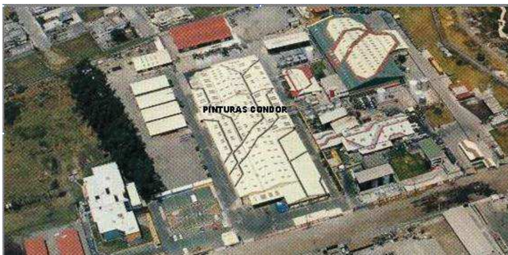
FIGURA 8. Avenida Cusubamba OEI- 365 y Manglar Alto sector Guajalo PINTURAS CONDOR
