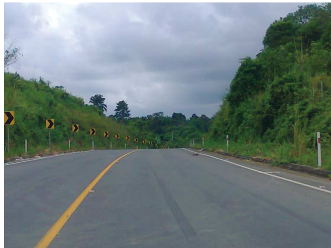
Figura 21. Vía completamente señalizada
