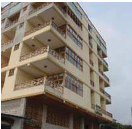
Figura 1. Vista de la fachada exterior
