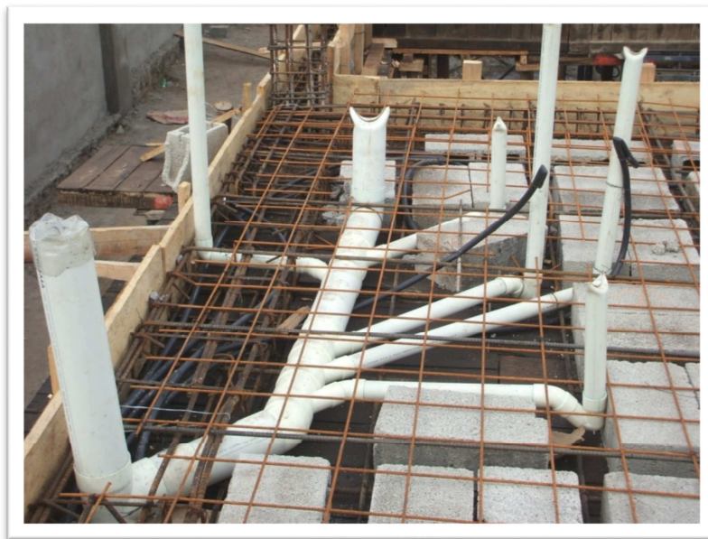
Figura 2.1. Construcciones de Tryskelwork Soluciones S.A.
