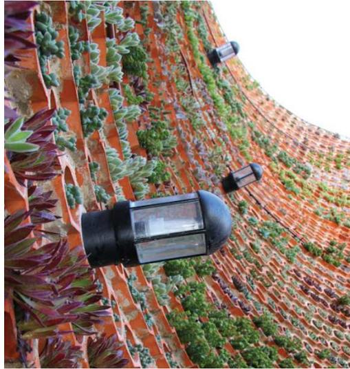
*Figura 40.* Vista de orificios de cerámica en el sistema Eco.bin.
